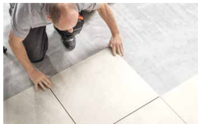
3 Bepaal het voegeraster en leg de kurkranden dicht tegen elkaar.
