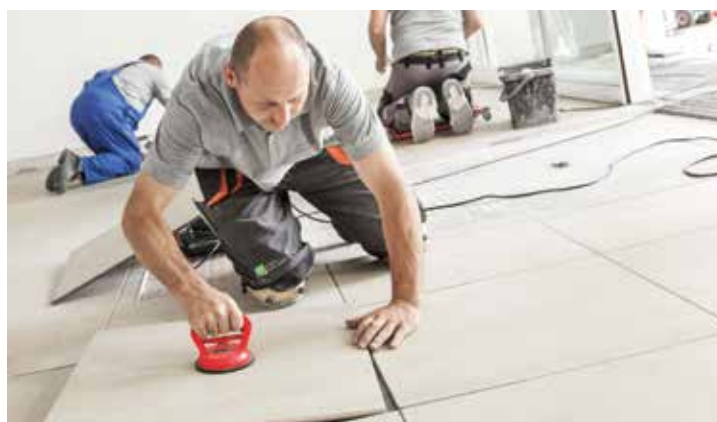
5 Drytile tegels zijn op elk moment eenvoudig te vervangen. Snijd gewoon de voeg open, verwijder de tegel met een zuignap en plaats een nieuwe tegel.
