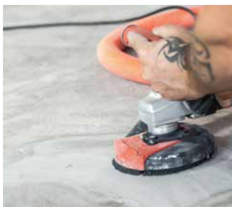
2 Bewerk de vloer indien nodig opnieuw om ervoor te zorgen dat aan de vereisten voor vlakheid wordt voldaan.
