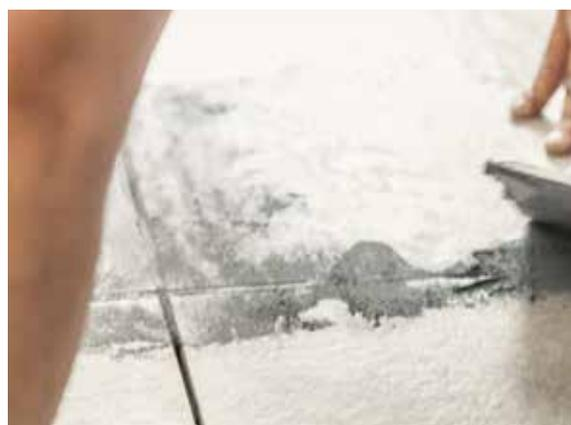
4 Jointoyer les carreaux avec un mortier adapté au système. Respecter le dosage en eau indiqué par le fabricant dans les instructions fournies.
