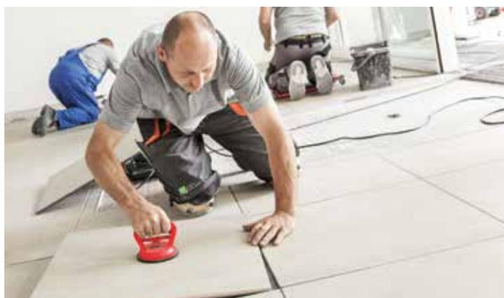
5 Les carreaux Drytile sont faciles à remplacer à tout moment. Découper le joint, soulever le carreau à l'aide d'une ventouse de levage et installer le nouveau carreau.
