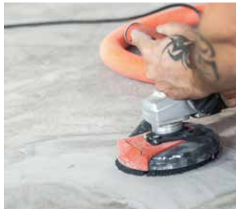
2 Boden ggf. nachbearbeiten, um die Anforderungen an die Ebenheit zu gewährleisten.
