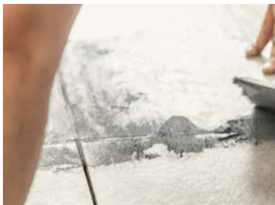
4 Fliesen mit systemeigener Fugenmasse verfugen. Wichtig ist dabei das richtige Mischungsverhältnis der Fugenmasse mit Wasser gemäß Angaben des Herstellers.
